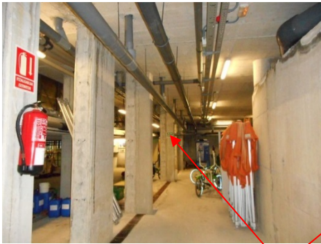
SEÑALIZACION ERRONEA, INDICA SALIDA Y ESTA EN COLUMNA
